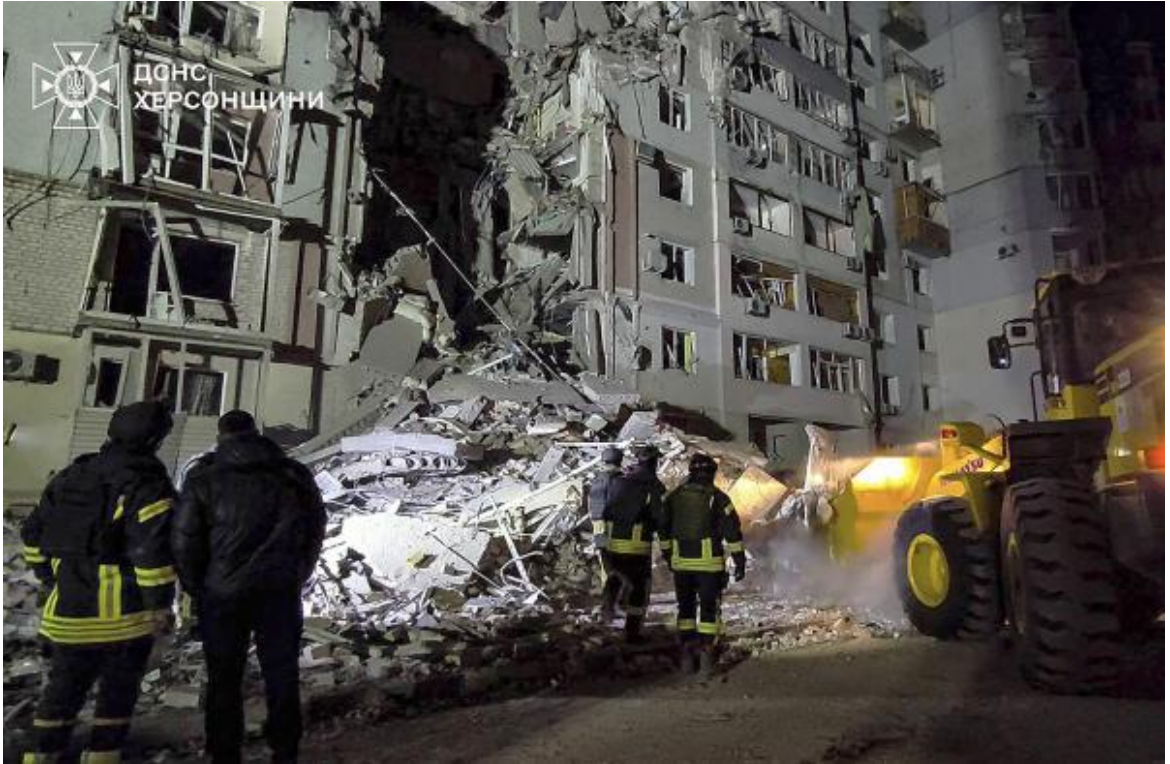
Ukrayna'nın Kherson kentindeki ok katlı bir apartman 20 řubat 2025'te Rus saldırısı sonucu aęır hasar grd. Fotoęraf: AP
